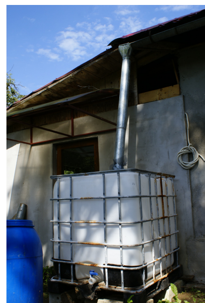
Le trop plein de la cuve de 3000L se déverse dans la 1000L.
